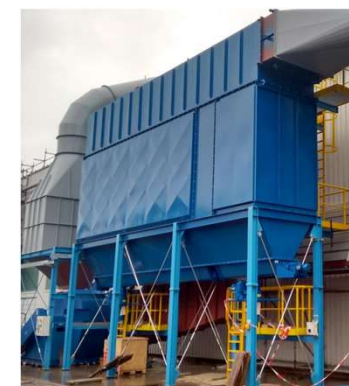
Traitement des poussières : Filtres à Manches (FAM)
