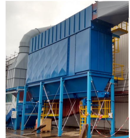
Traitement des poussières : Filtres à Manches (FAM)
